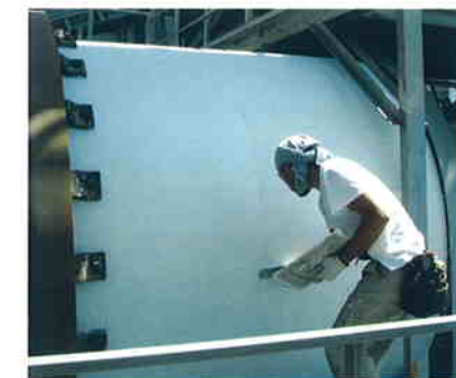
ドライヤーの外壁をコテ塗り
