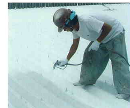
屋根をスプレー塗り
